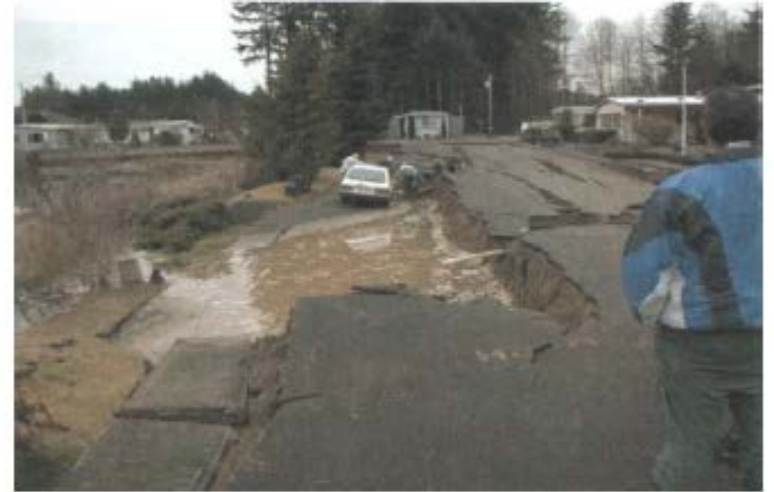
2001 Nisqually, WA depreminde Pajaro Sunset Lake'de yanal yayılma
