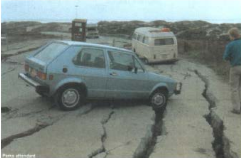
1989 Loma Prieta depreminde devlet parkı yakınında oluşan yanal yayılma
