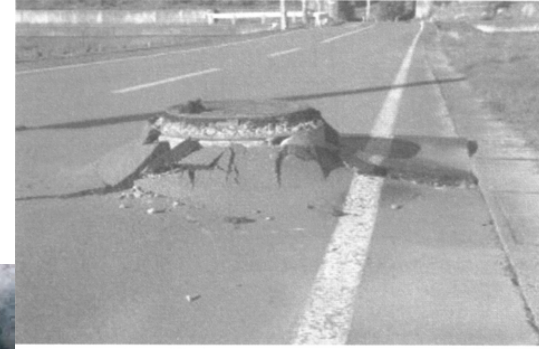
Şekil 4.23. 2004 Niigata Chuetsu depreminde sivilaşma sonucu muayene bacası yükselmesi
